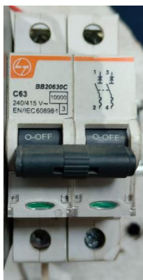
Fig.30. L&T 10000 BB20630C MCB
